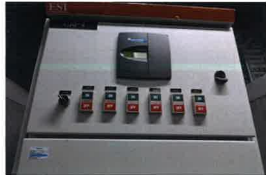
ระบบแสดงผล Capacitor Bank
