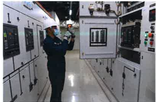
ตรวจสอบอุณหภูมิด้วยกล้องอินฟราเรด
