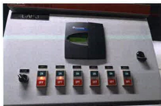
ระบบแสดงผล Capacitor Bank
