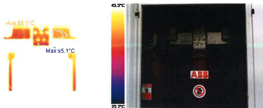
ตรวจสอบอุณหภูมิด้วยกล้องอินฟราเรด
