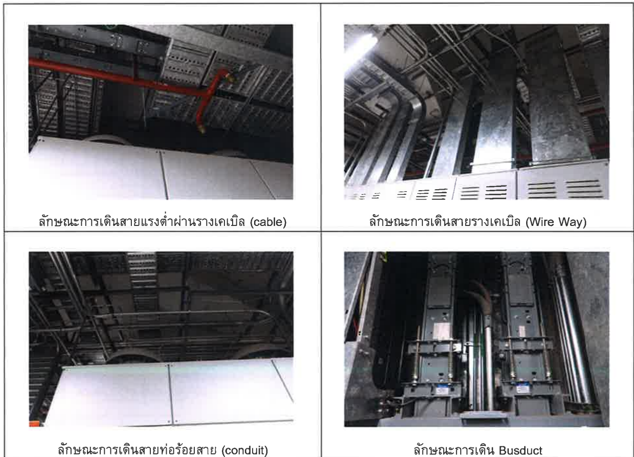
รูปที่ 4 การตรวจสอบการเดินสายระบบไฟฟ้า
