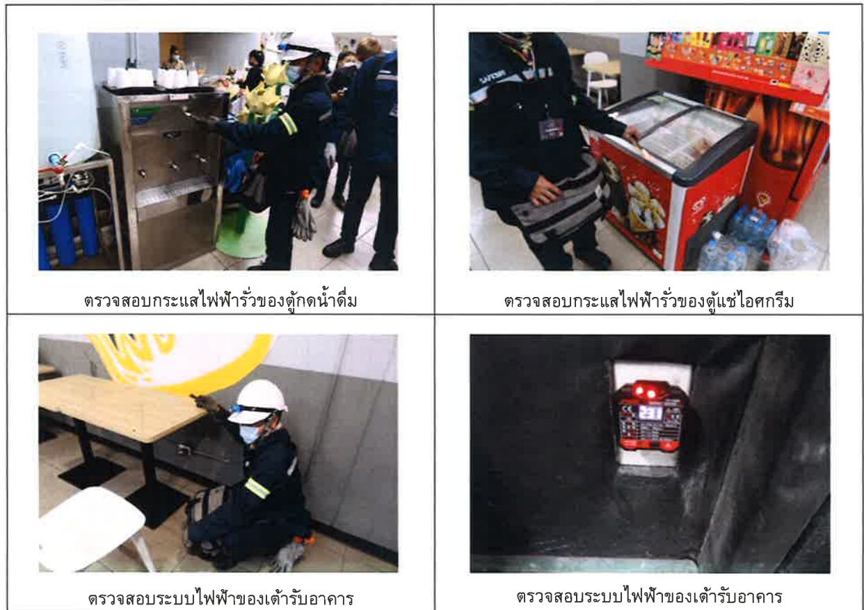
รูปที่ 6 การตรวจสอบการเดินสายและติดตั้งอุปกรณ์ไฟฟ้า
