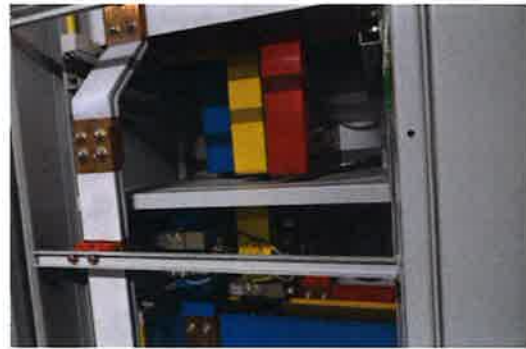
ตรวจสอบบัสบาร์ภายในตู้
