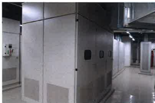
การตรวจสอบหม้อแปลง TR7 ขนาด 1600 kVA
